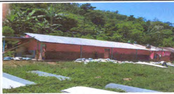
Foto 6: Se evidencia el cambio del techo de la escuela.
