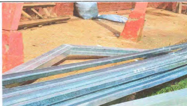
Foto 4: Se evidencia la unión de las costaneras que se utilizaron para cambiar el techo de la escuela
