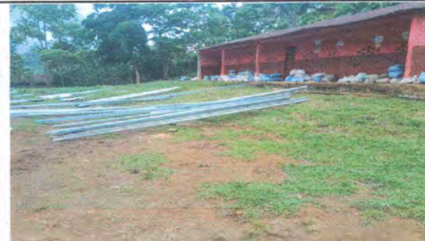
Foto 2: Se evidencia las costaneras utilizadas para poder colocar el techo del establecimiento
