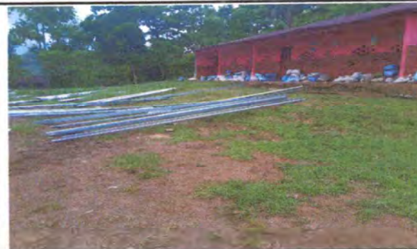
Foto 2: Se evidencia las costaneras utilizadas para poder colocar el techo del establecimiento
