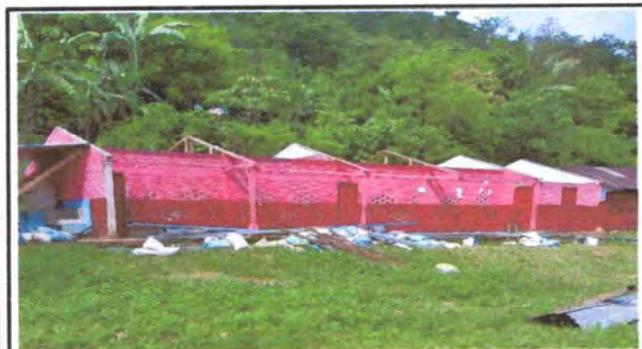
Foto 3: Se evidencia la dismantelación del anterior techo con el que contaba la escuela
