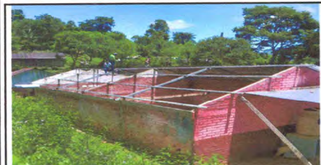
Foto 5: Se evidencia la colocación de las costaneras en la escuela.
